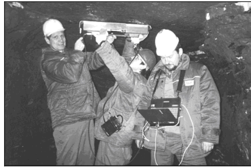
Рис. 1. Измерения в кровле КВШ георадаром с антенным блоком АБ-400
